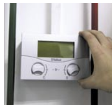
3. korak Kao sobni korektor može se koristiti upravljački dio regulatora calorMATIC 630, u tom se slučaju dodatno naručuje kućište VR 55.
