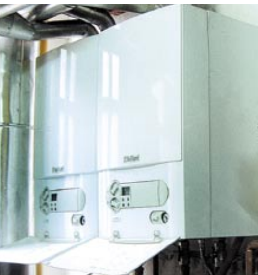
Gospodin Lonjak originalno je riješio grijanje u robnoj kući "Međimurka" u Čakovcu. Umjesto obnavljanja stare, velike kotlovnice, postavljeni su Vaillantovi zidni, uglavnom kondenzacijski, uređaji
