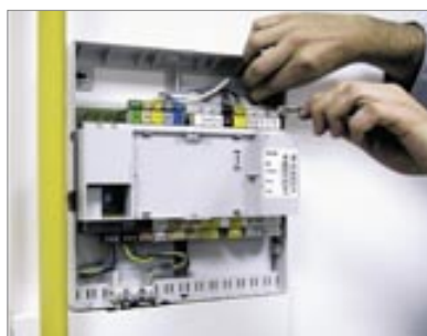
1. korak Montaža podnožja regulacije calorMATIC 630. Spajanje napona, crpki te svih osjetnika.
