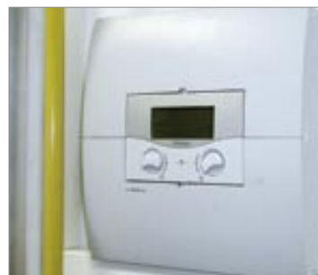
6. korak Osvjetljeni tekstualni displej nove regulacije calorMATIC 630 prikazuje aktualno stanje rada sustava pomoću grafike i teksta na hrvatskom jeziku.
