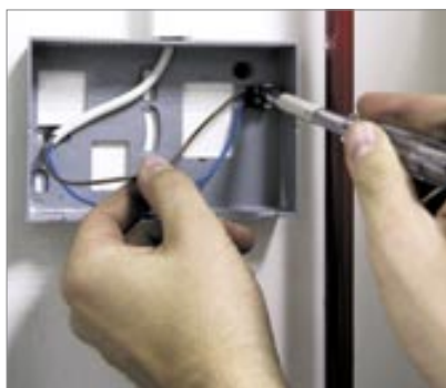
1. korak Montaža podnožja sobnog korektora VR 90 ili kućišta VR 55.
