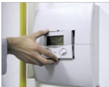
5. korak Spajanje regulatora sa središnjim upravljačkim dijelom.
