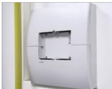
4. korak Izgled regulacije calorMATIC 630 nakon postavljanja poklopaca, a bez središnjeg upravljačkog dijela.
