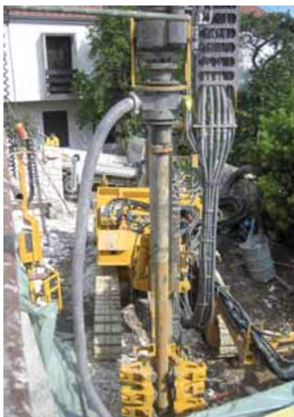
Bušenje upojnog-izljevnog bunara (zdenca) u Novom Vinodolskom
