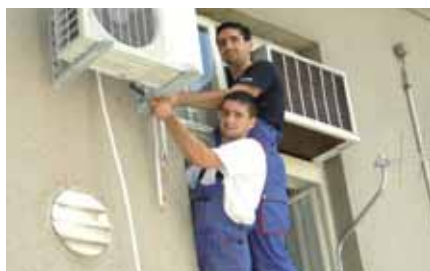
Djelatnici obrta Džambo instalacije poklonili su svoj rad
