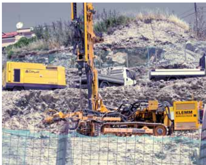
Bušenje bunara u Pazdigradskoj ulici u Splitu
